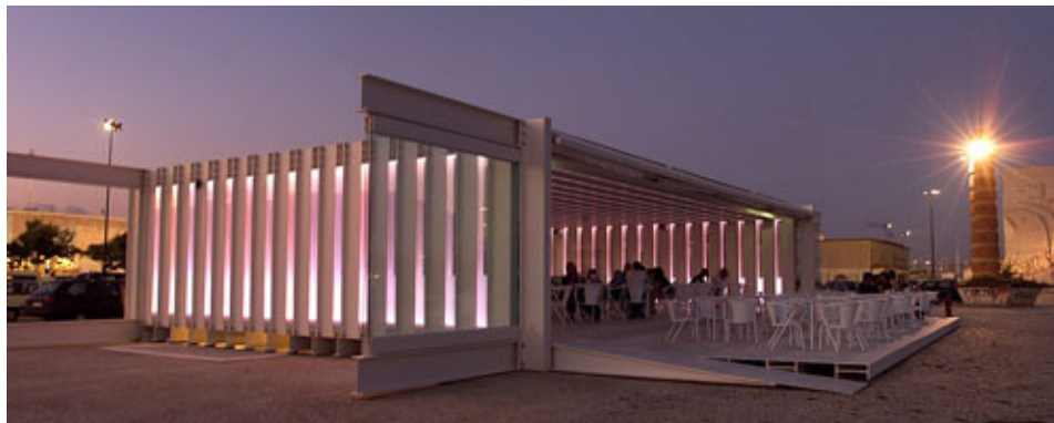
Imagen 1: A margen, imagen del propio restaurante. www.amargen.com
